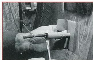
**7** ラジアルシールからパッチ部分の保護用ポリビニールを剥し、次にパッチ部分の保護用ポリビニールを剥し持ち手を作るようにポリビニールを貼り直して下さい。(貼り付け面を汚さない為と、貼り付け後のエア-に抜きに役立ちます)付属の引き出しワイヤーにラジアルシールをセットし、パッチ部分の黒いゴム部分にケミカルセメント(#760)を少し塗りパッチ面に書かれているビード方向の矢印がタイヤのビード方向に向くように引き出して下さい。
