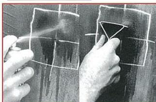
**2** ラジアルシールのパッチ部分を傷口の中心に合わせてパッチの周り15mmの部分に外郭線を引いて下さい。バッファー液(#704A)をスプレーし、バッファー液が乾燥する前に、スクレーパー(#933)でシリコンを削り取って下さい。
